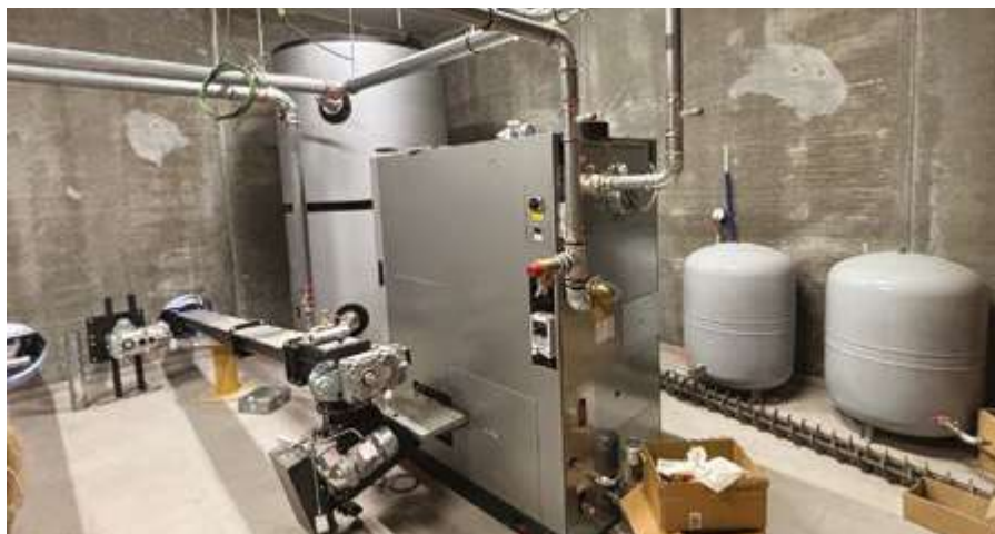
Chaudière Biomasse IPALLE à Froyennes.
