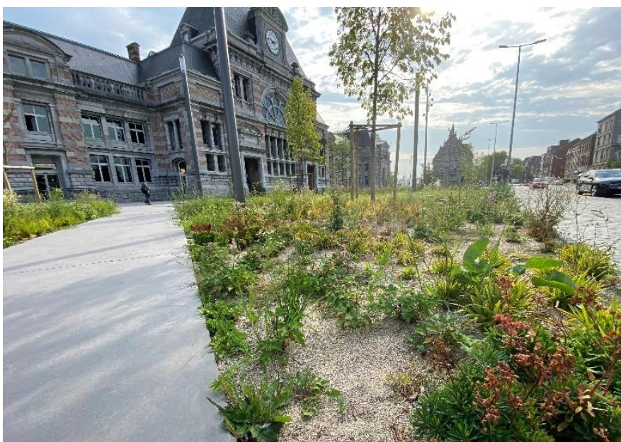
Source : IPALLE – Jardin de pluie devant la Gare de Tournai (désimperméabilisations des sols)
