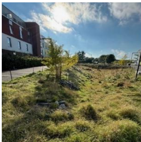
Noue paysagère plantée - Source : IPALLE - Ath - Square de la Demi-Lune
