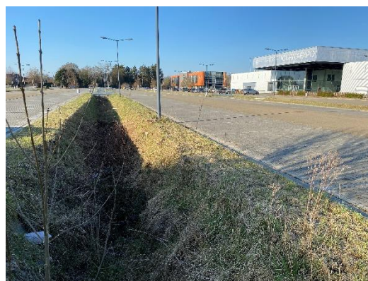
Noue paysagère plantée - Source : IPALLE – Parking de Tournai Expo
