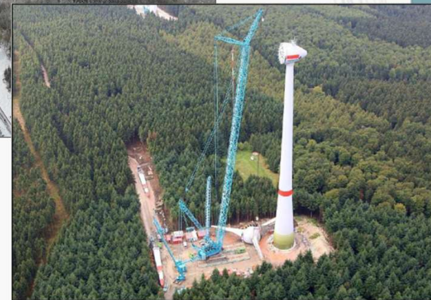
Construction d'une éolienne en zone forestière en Allemagne (source :www.juwi.de).
